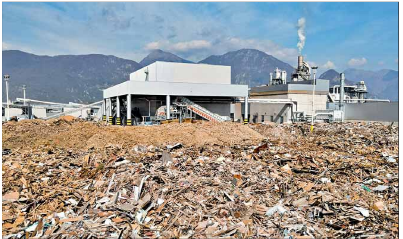
Außenansicht der Recyclinganlage von Fantoni zur nachhaltigen Verarbeitung von Holzabfällen
